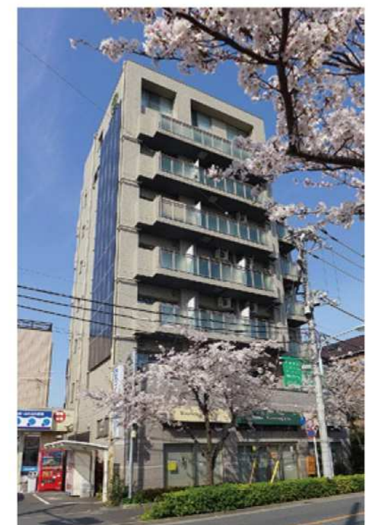
2006 / 丸喜 (株) 齋藤組 東京支店 [オフィスビル]
